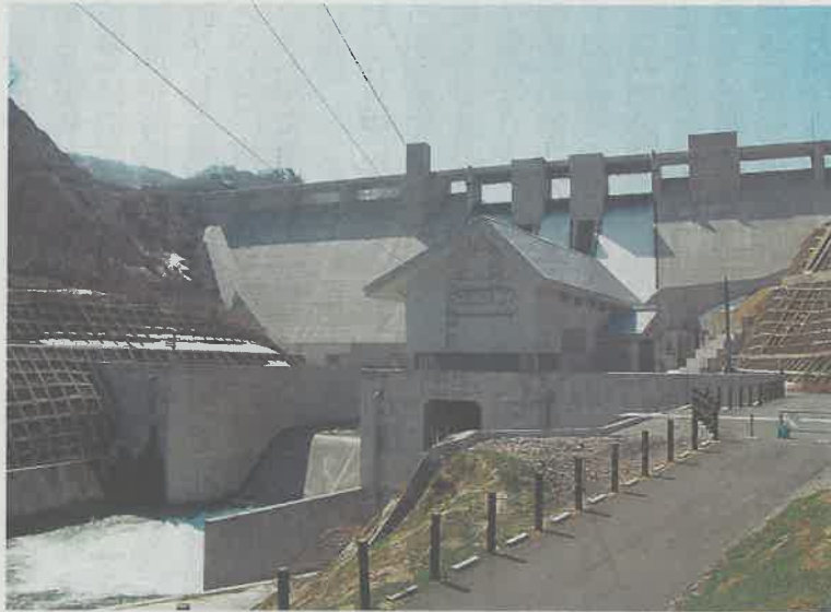
FIT枠として売電先が決まった水力発電所の一つ、小国町の横川発電所 (県企業局提供)
