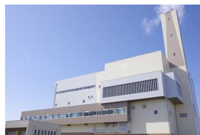
鶴岡市ごみ焼却施設
