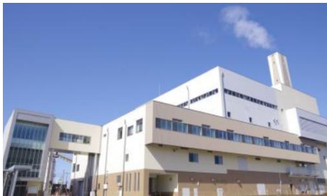
鶴岡市ごみ焼却施設
