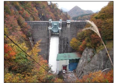
大沢川発電所
